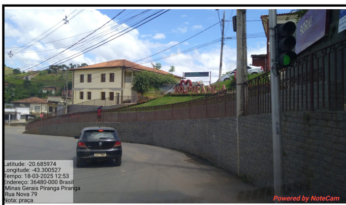
Descrição: Guarda corpo da Praça Dr. Solon
