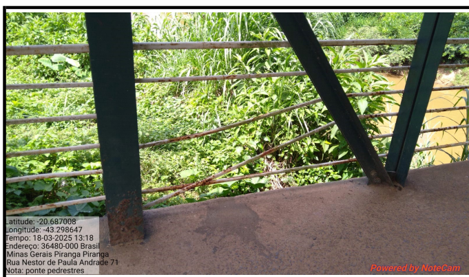
Descrição: Guarda-corpo Ponte localizada no Bairro Copasa
