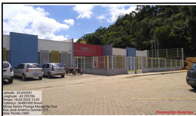
Descrição: Alambrado do CMEI
