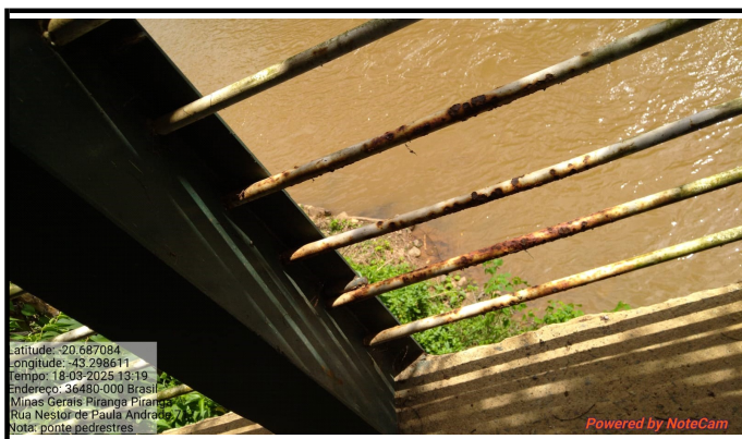
Descrição: Guarda-corpo Ponte localizada no Bairro Copasa
