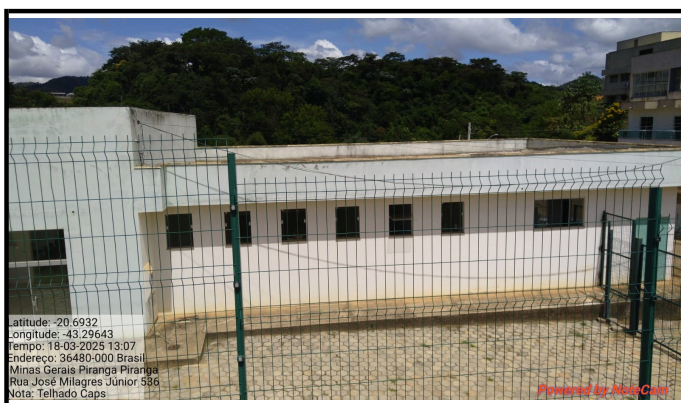
Descrição: Alambrado e telhado do CAPS
