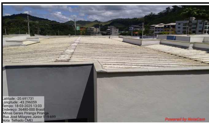
Descrição: Telhado do CMEI
