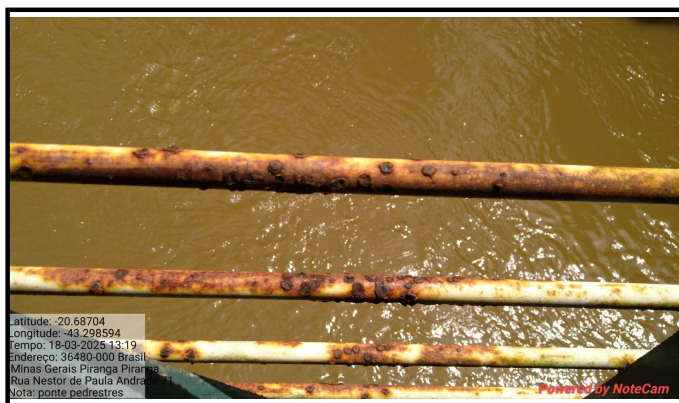
Descrição: Guarda-corpo Ponte localizada no Bairro Copasa
