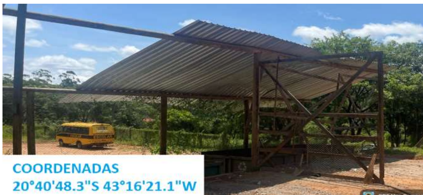
Foto 2 – Usina – local de instalação dos contêineres para acondicionamento temporário de resíduos sólidos, até a coleta e envio a destinação final.
