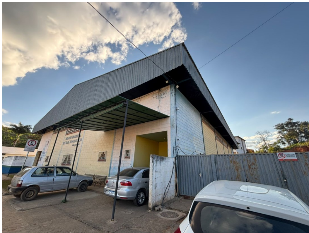
Foto 1: Fachada Frontal do Ginasio Poliesportivo
