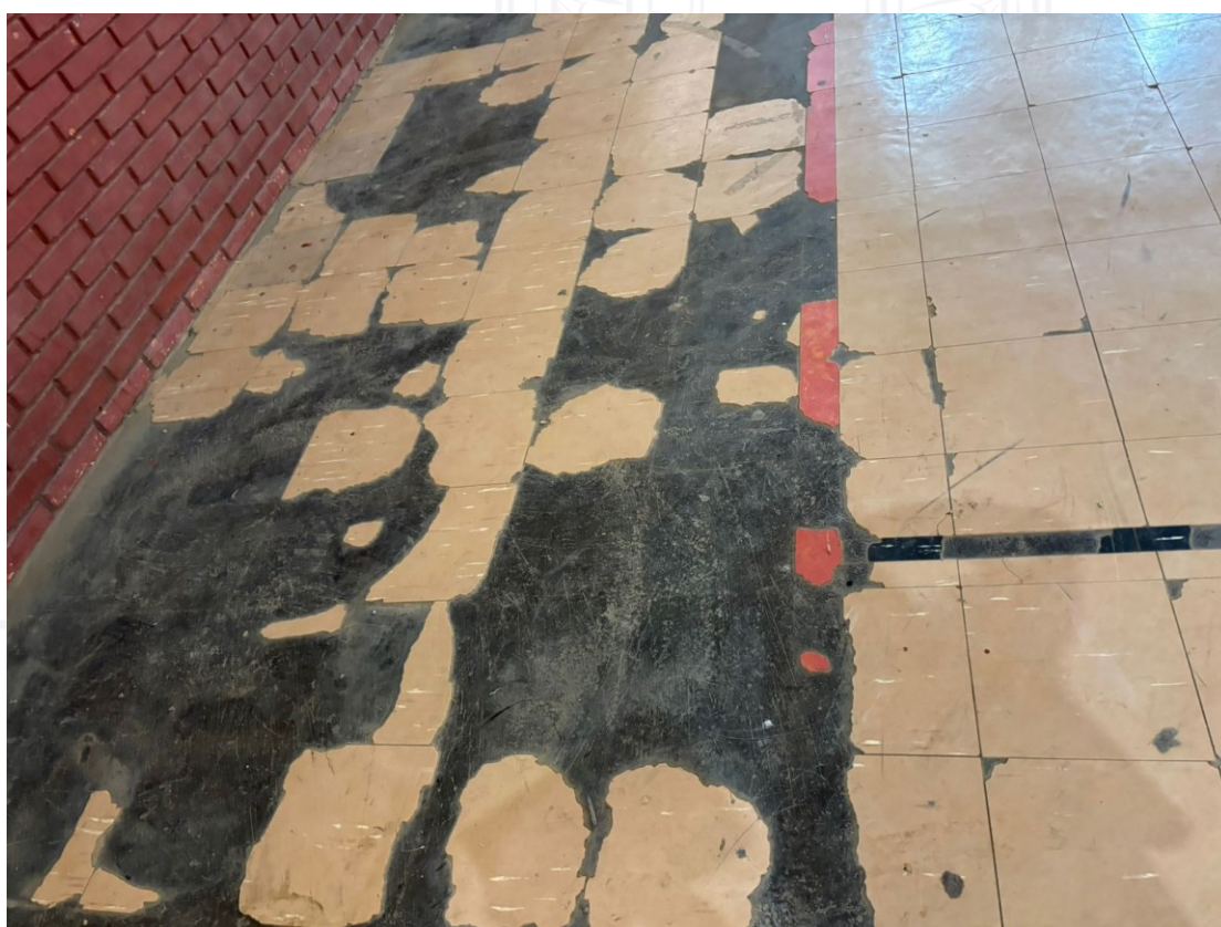
Foto 4: Piso da Quadra
