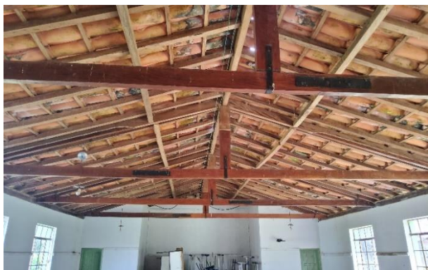
Foto 01: Telhado Salão de Eventos
