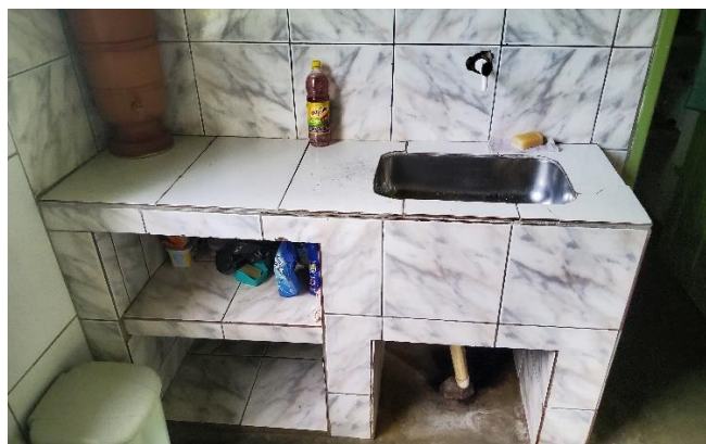
Foto 06: Pia a ser demolida
