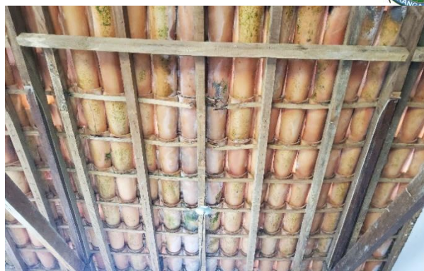
Foto 02: Telhado Salão de Eventos
