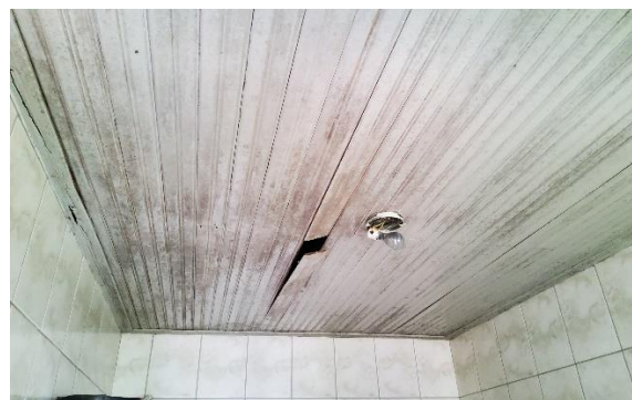
Foto 04: Forro a ser removido
