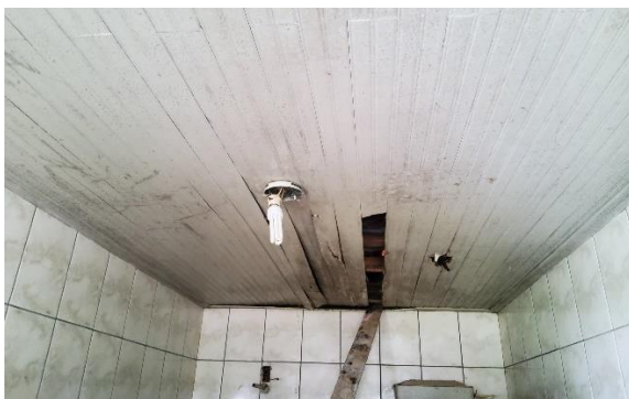
Foto 03: Forro a ser removido
