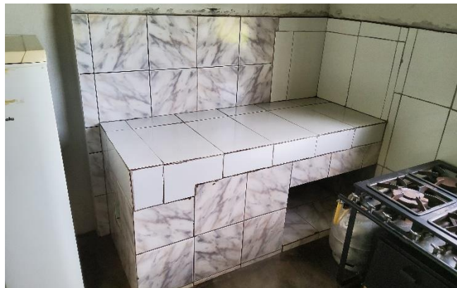
Foto 07: Balcão a ser demolido
