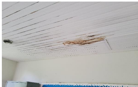
Foto 05: Forro a ser removido
